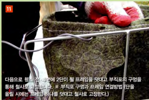
2단을 쌓기 위해 1단과 같은 방법으로 먼저 칸이 되는 부분에 프레임의 덧대고 철사로 고정한다. (1단과 2단 사이 바닥 칸은 만들지 않음)
